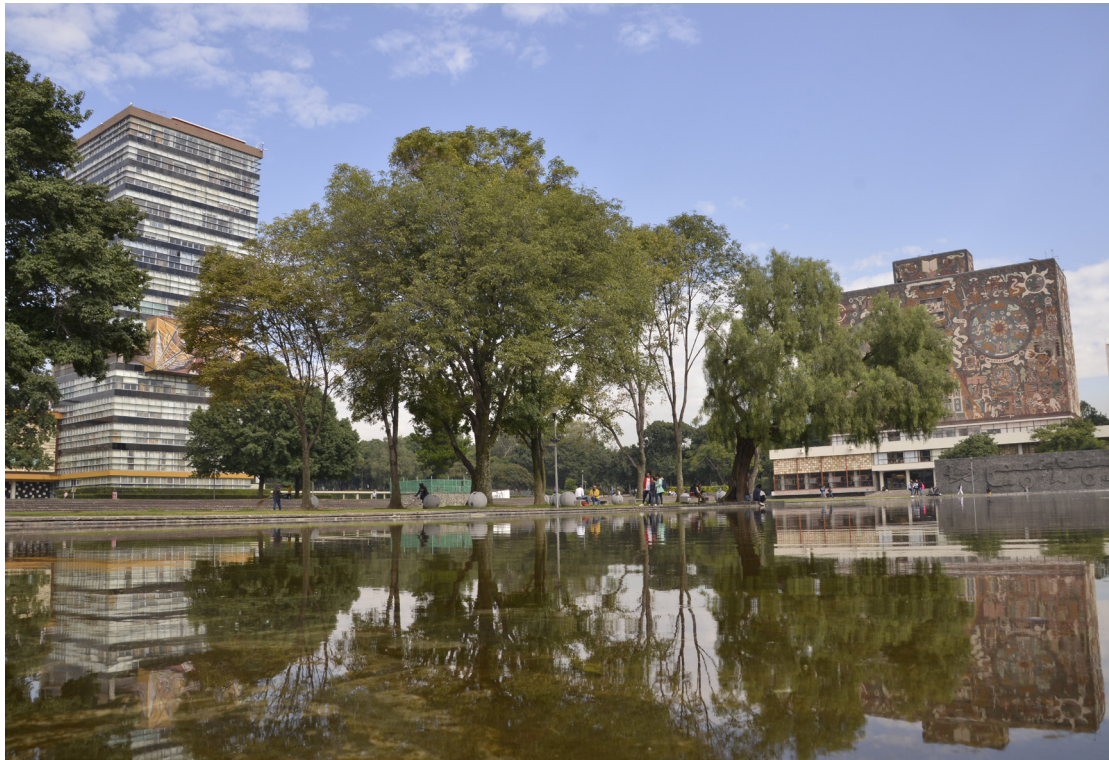
Fig. 1. General view of the Torre de Rectoría and the Biblioteca Central from the water mirror located in the central campus. Source: Coordinación de Producción Audiovisual, Facultad de Arquitectura, UNAM / fotografía: Rafael Carlos Guerrero, 2019.
