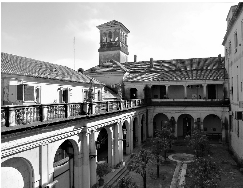
Fig. 10 – Facultad de Ciencias Jurídicas. Patio “de los naranjos”, lado oeste. Foto: arq. Lelis Labuckas, 2019.
