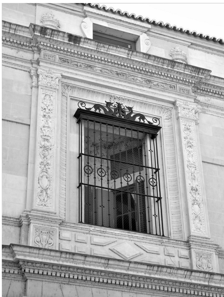
Fig. 08 – Detalle de ornamentación y herrería en la ventana del cuerpo esquinero oeste. Foto: arq. Lelis Labuckas, 2019.
