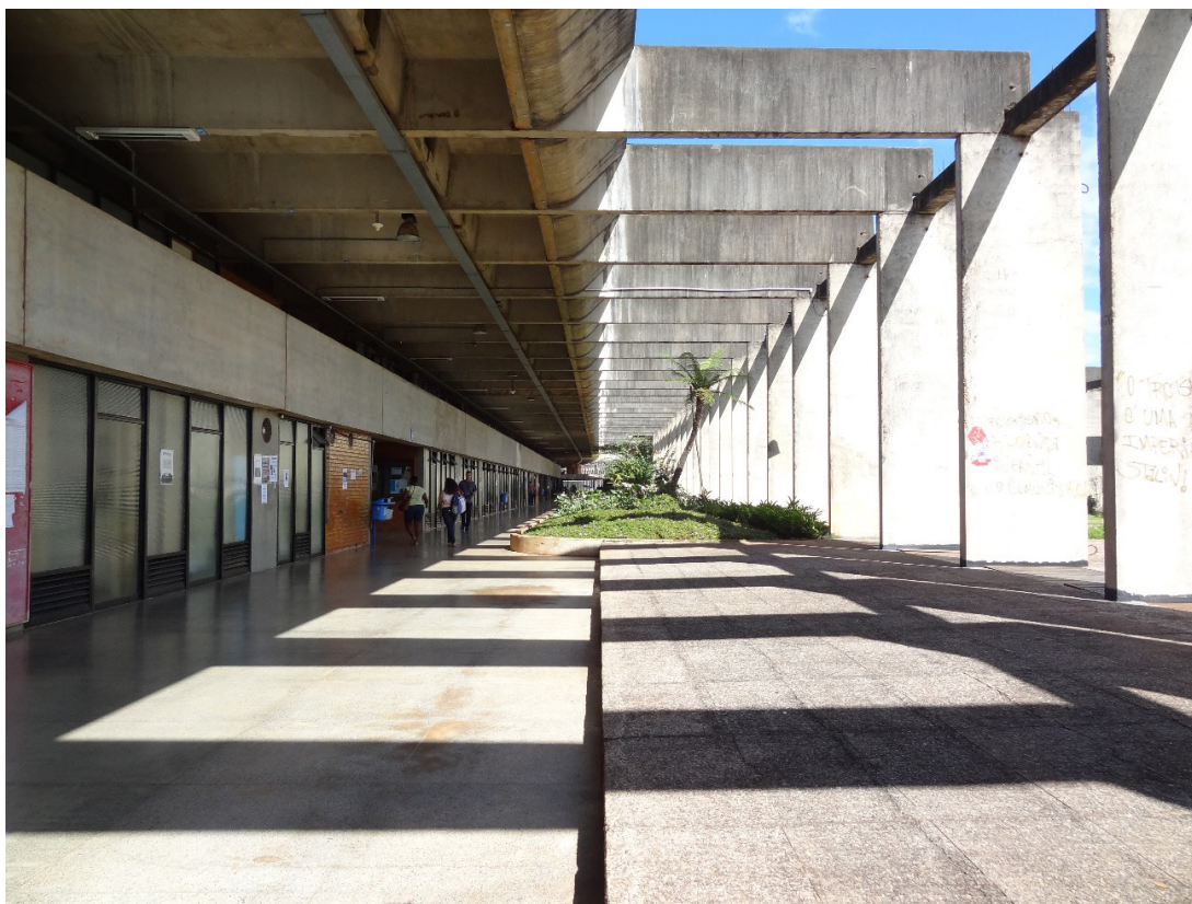
Fig. 5. Interior do Instituto Central de Ciências. Autor: Oscar Niemeyer (1962). Foto: Eduardo P. Rossetti.
